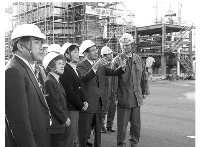
三菱化学鹿島事業所の事故現場で説明を受ける（左から）立原鹿嶋市議、大内茨城県議、あやべ北関東ブロック国政対策委員長、塩川衆院議員＝12月27日・鹿嶋市内
