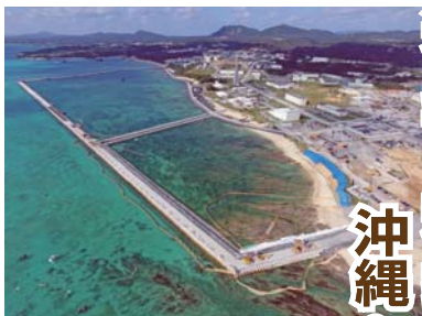
護岸で囲まれた区画。12月14日、沖縄辺野古崎付近（しんぶん赤旗提供）
